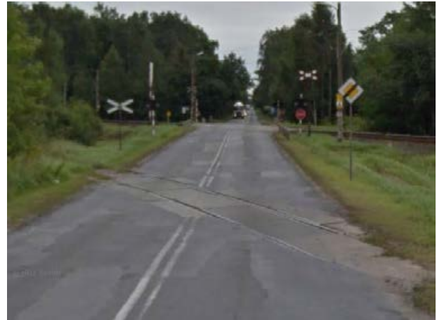
Rys. 109: Przykład bezpośredniego sąsiedztwa skrzyżowań z czynną i nieczynną linią kolejową. Obydwa zdjęcia przedstawiają tę samą lokalizację z innej perspektywy.
